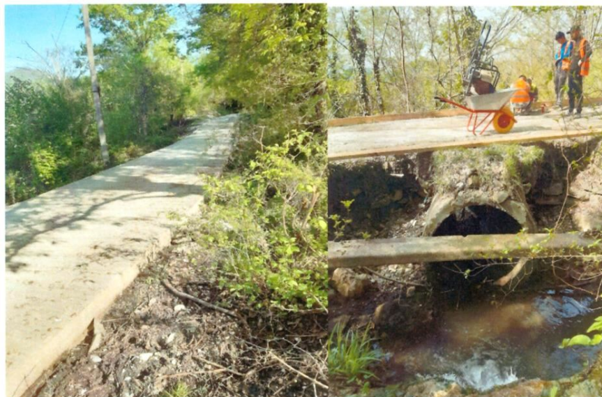
- Ремонт дорожного полотна по ул. Шаумяна с. Хлебороб – 1000 тыс. руб.
